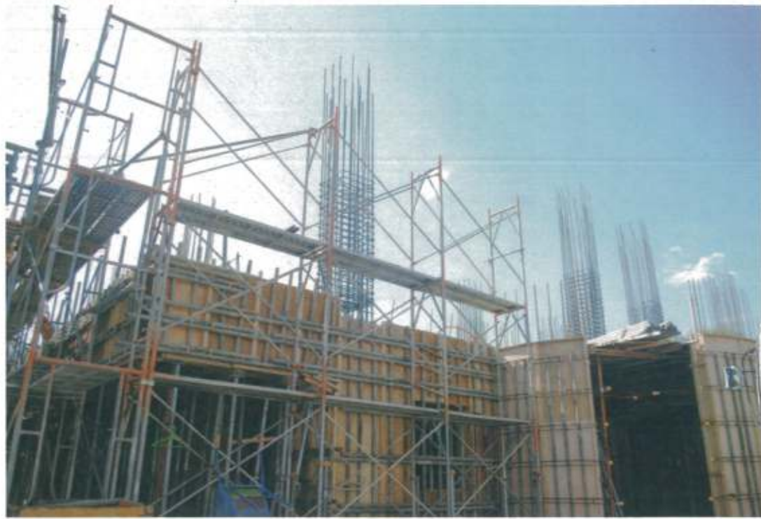
法人屋舎建替え中 来年2月の竣工に向けて順調に進んでいます
